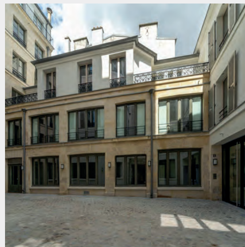
Immeuble 72A rue du Château d'eau - Paris 10
